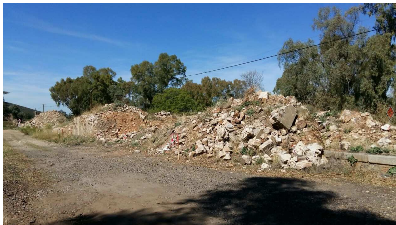
Fotos realizadas después de la demolición, el día 27-9-2023
